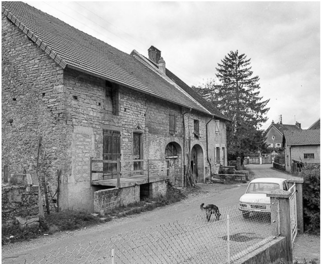
Façade antérieure vue de trois quarts gauche.
