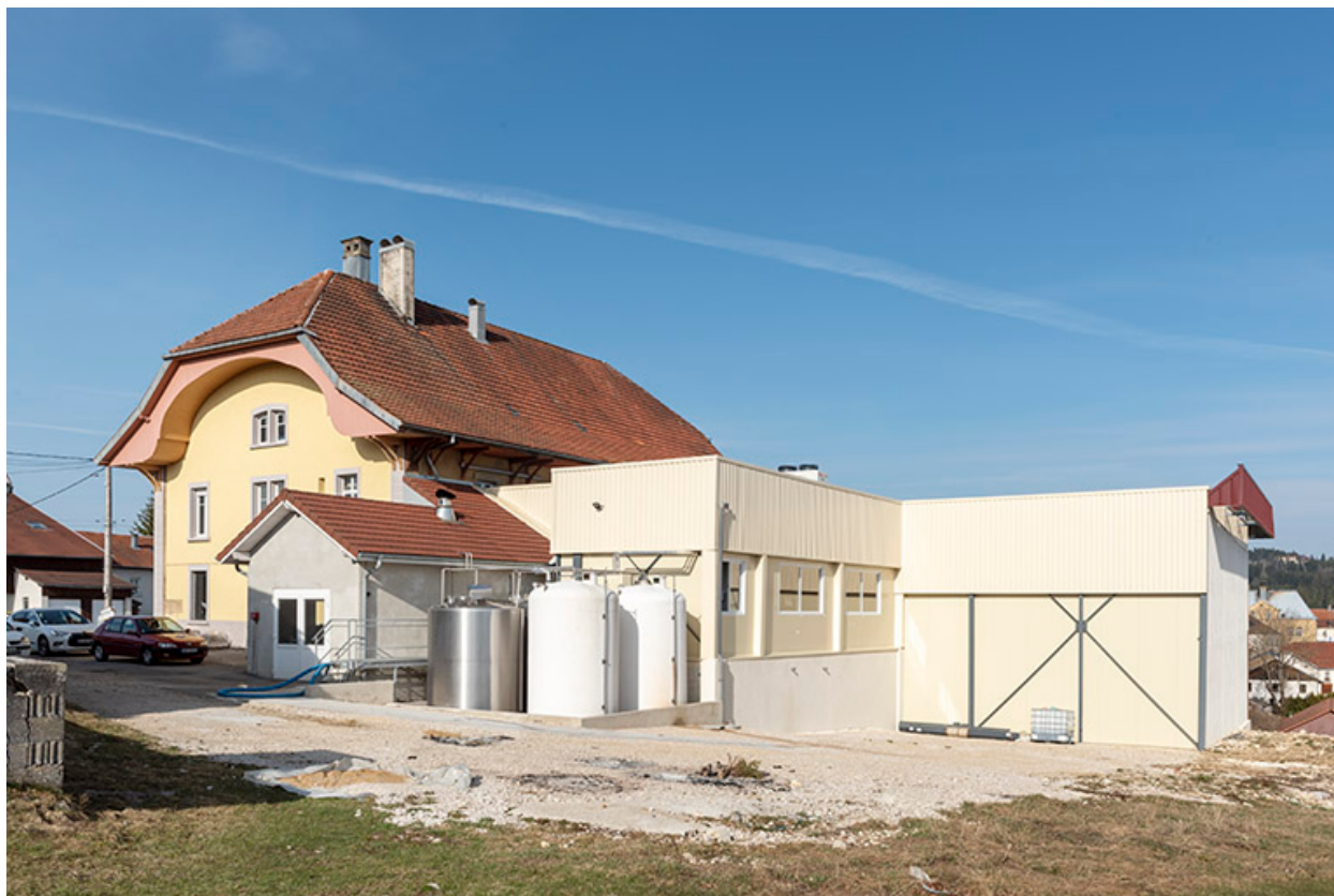
Façade latérale droite et extension, depuis l'est.
