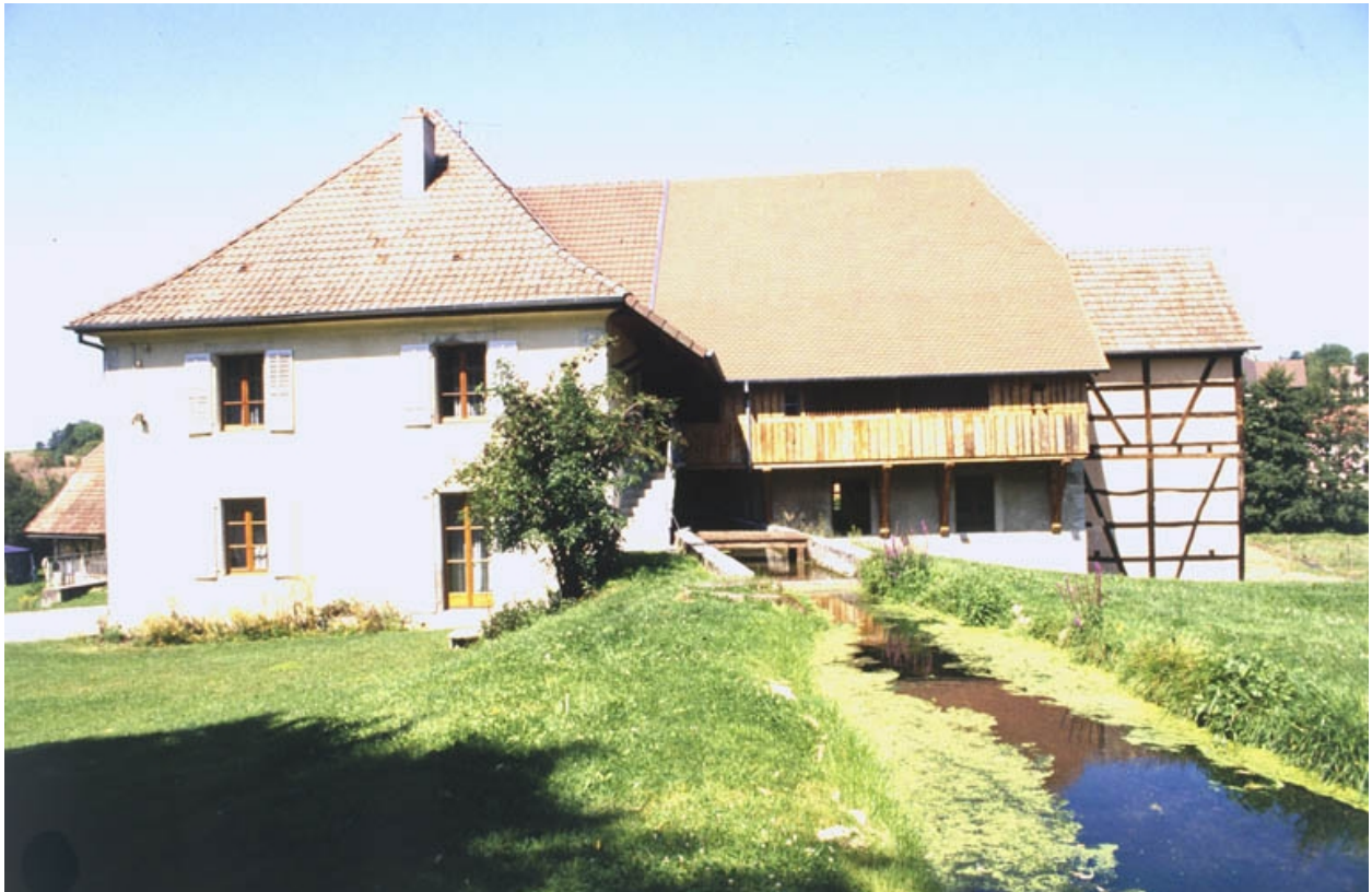
Vue d'ensemble depuis le sud-est. Au premier plan : le canal d'amenée.
