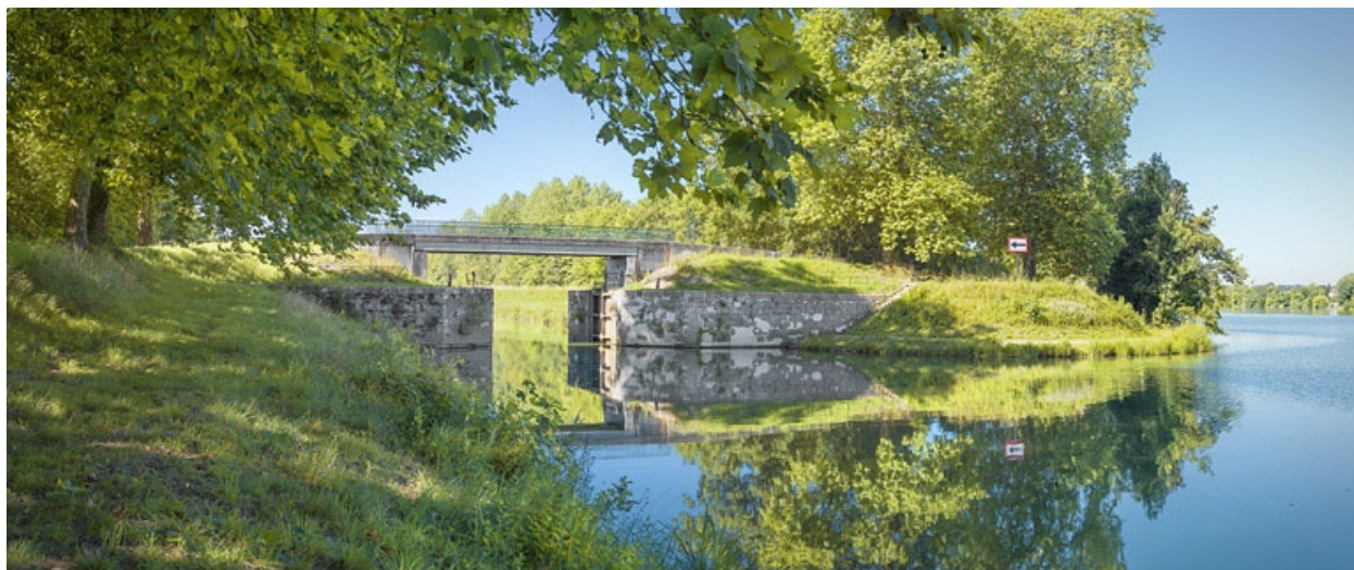
Vue d'ensemble d'amont.
