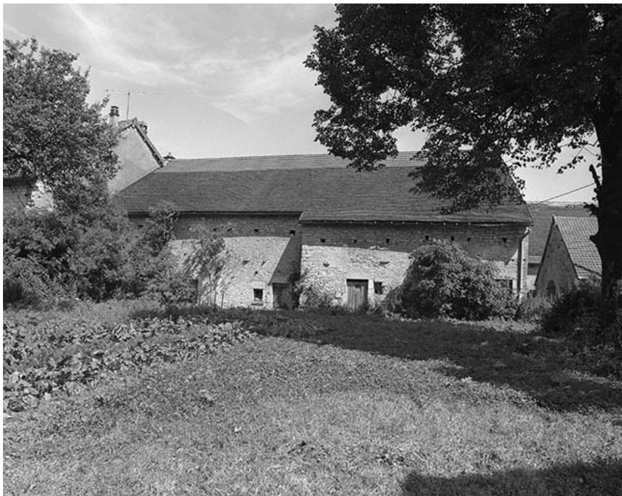
Ferme : façade postérieure.
