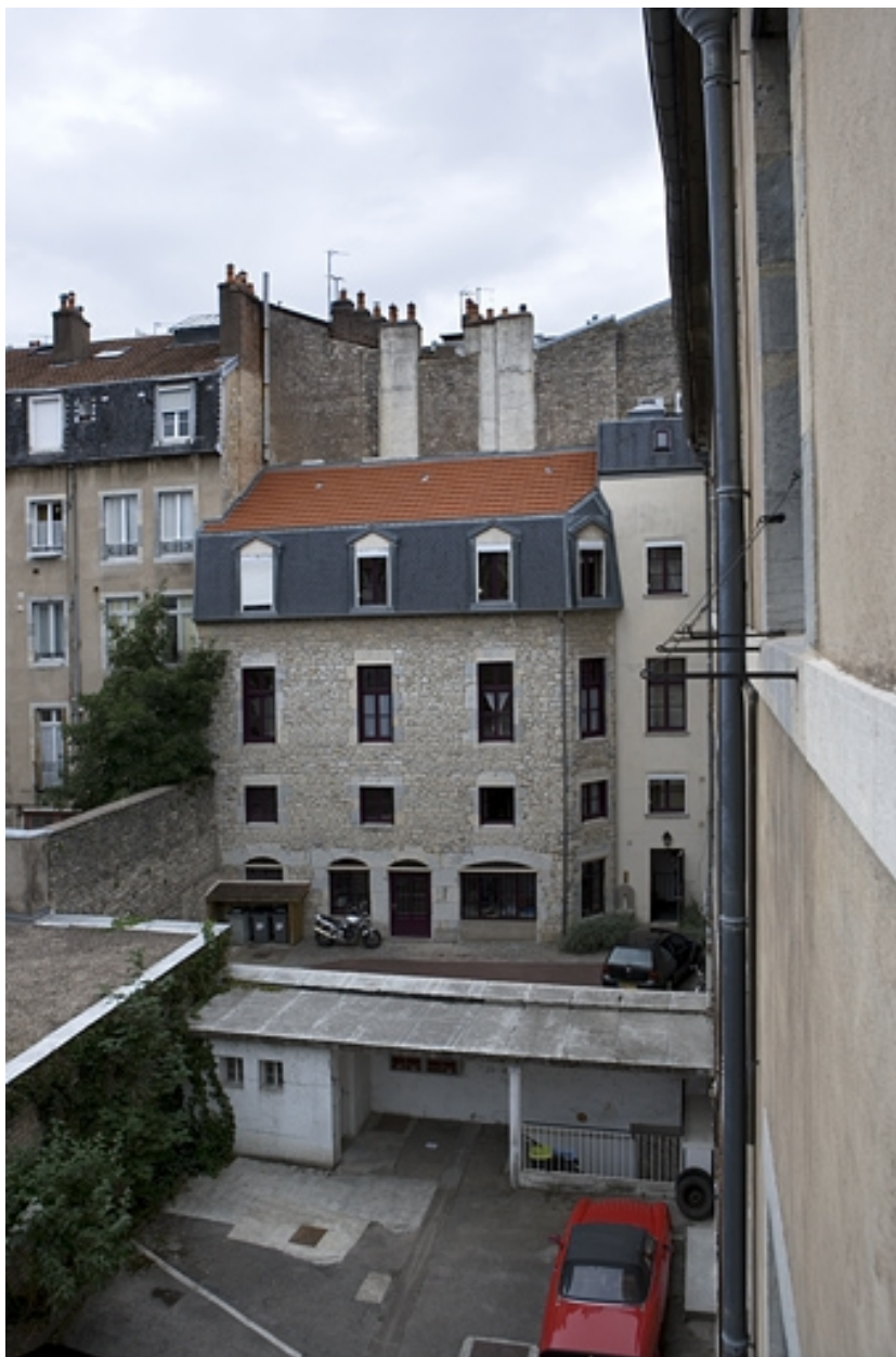
Vue d'ensemble de l'aile droite sur cour.
