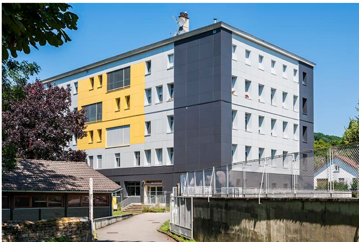
Façade latérale de l'internat après rénovation.
