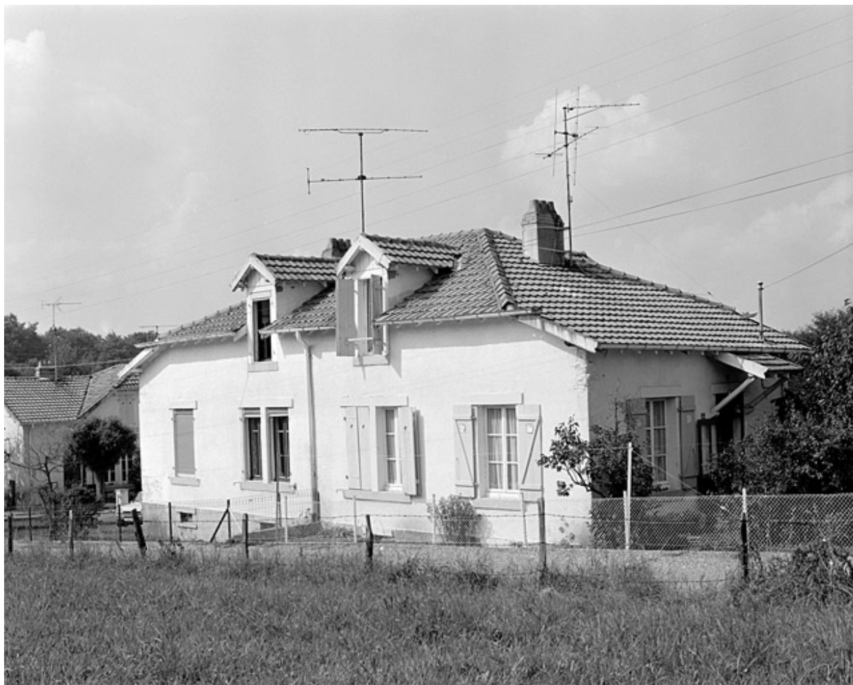
Maison jumelée en 1981.SRI. Enquête régionale sur les bâtiments industriels (1979-1981).
