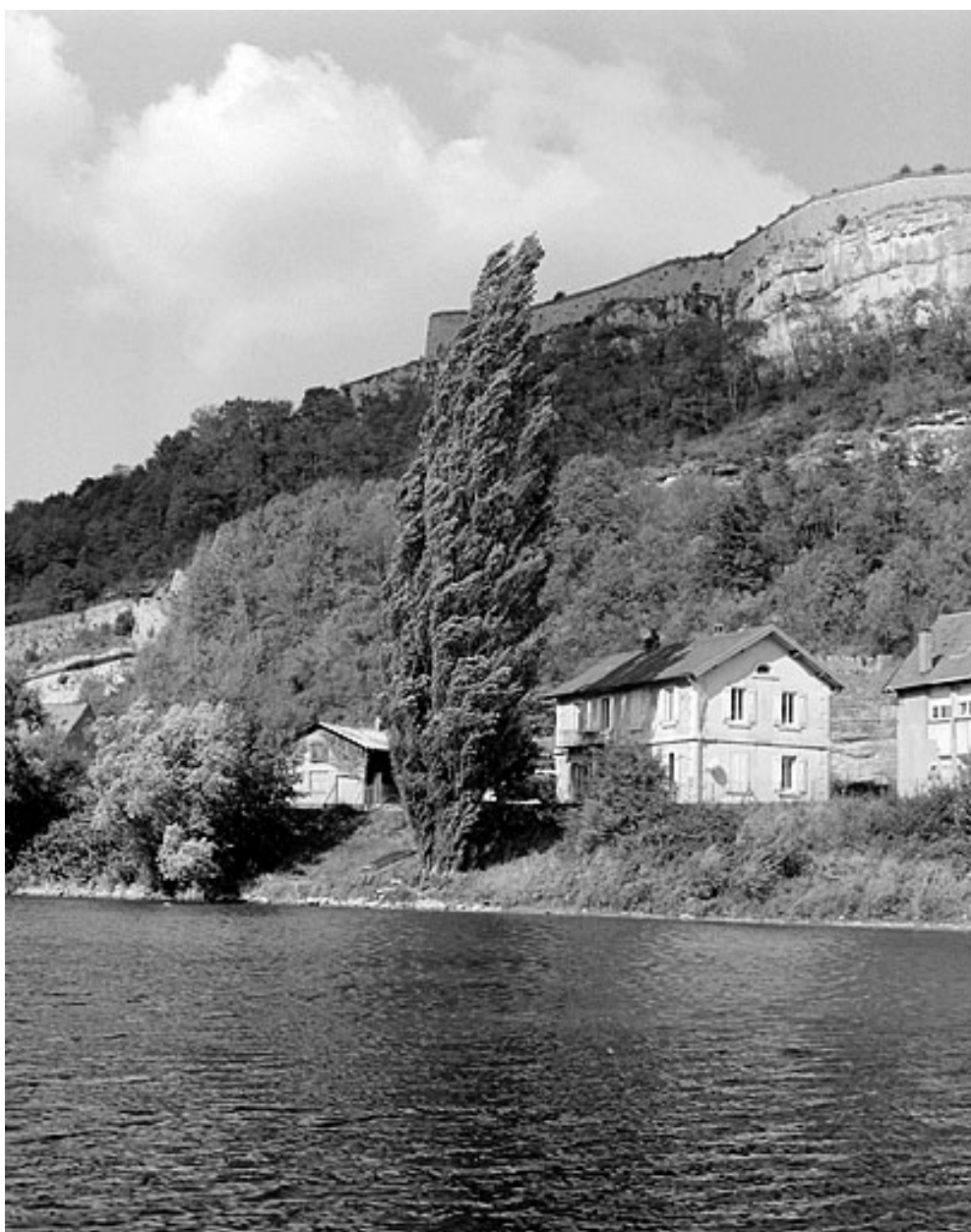
Façades postérieure et latérale gauche.
