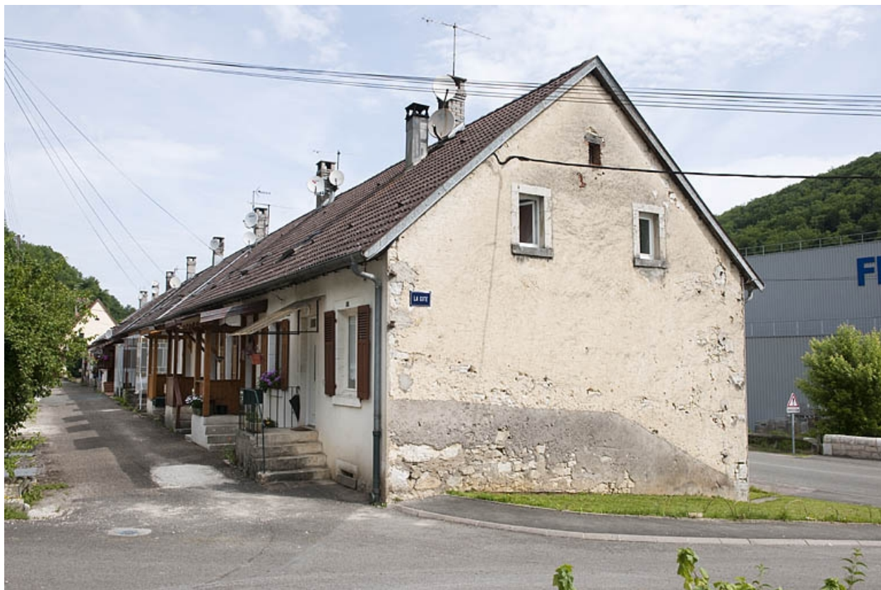
Logement d'ouvriers. Vue de trois quarts.
