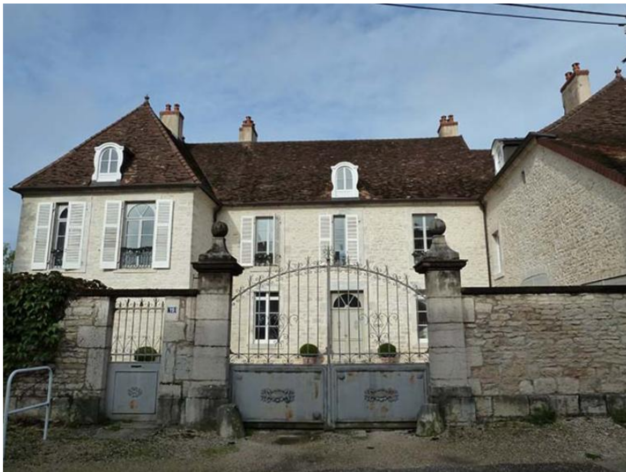
Vue générale sud
