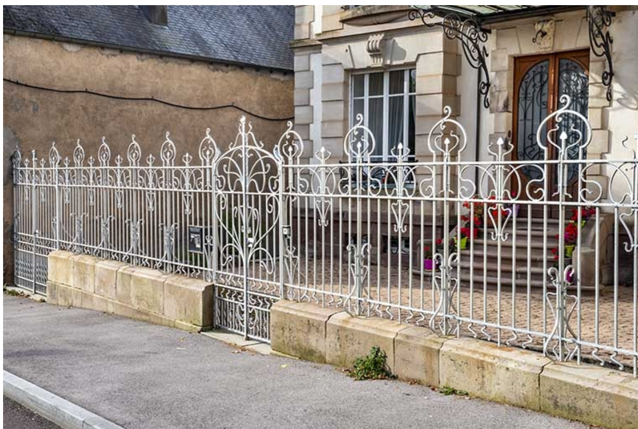
Grille de clôture.
