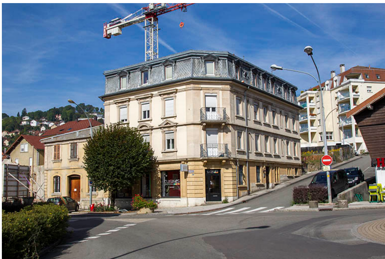
Façades antérieure et latérale droite.
