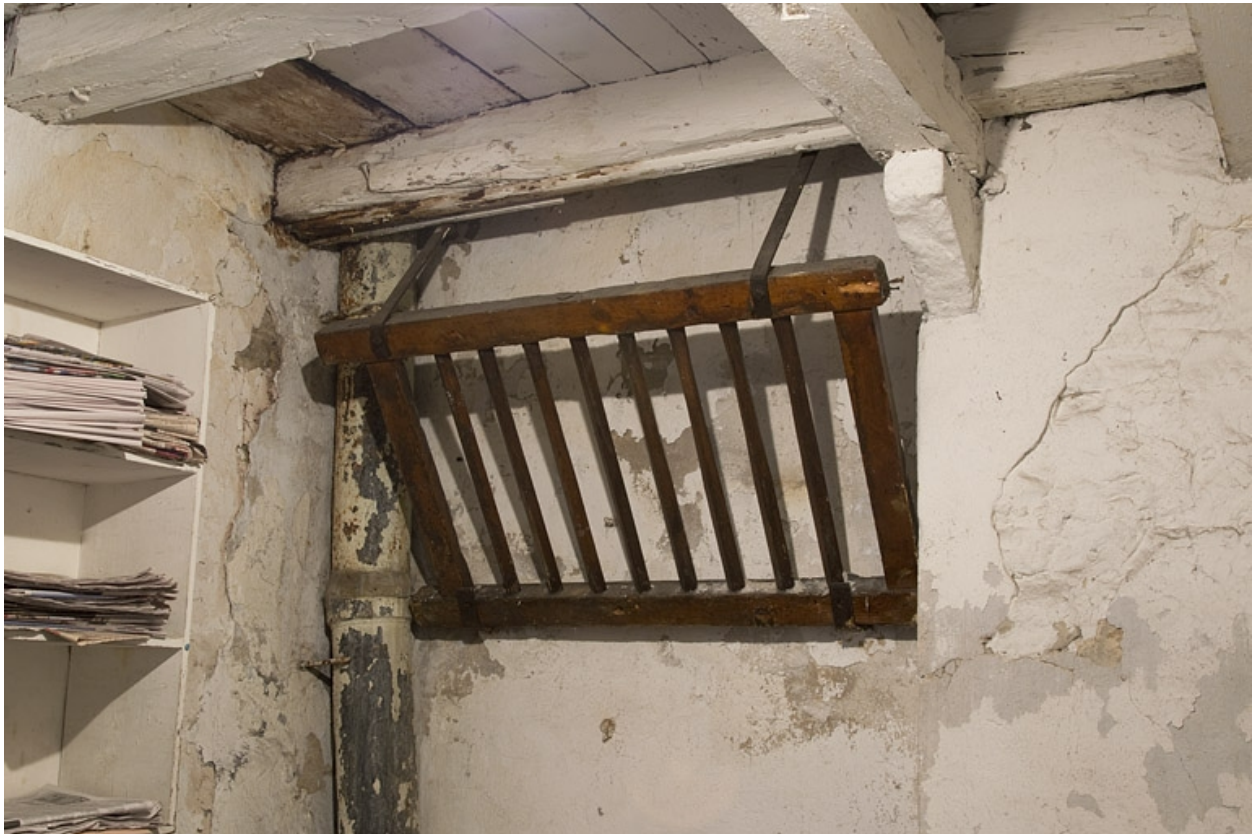
Ecurie : vue d'un râtelier.
