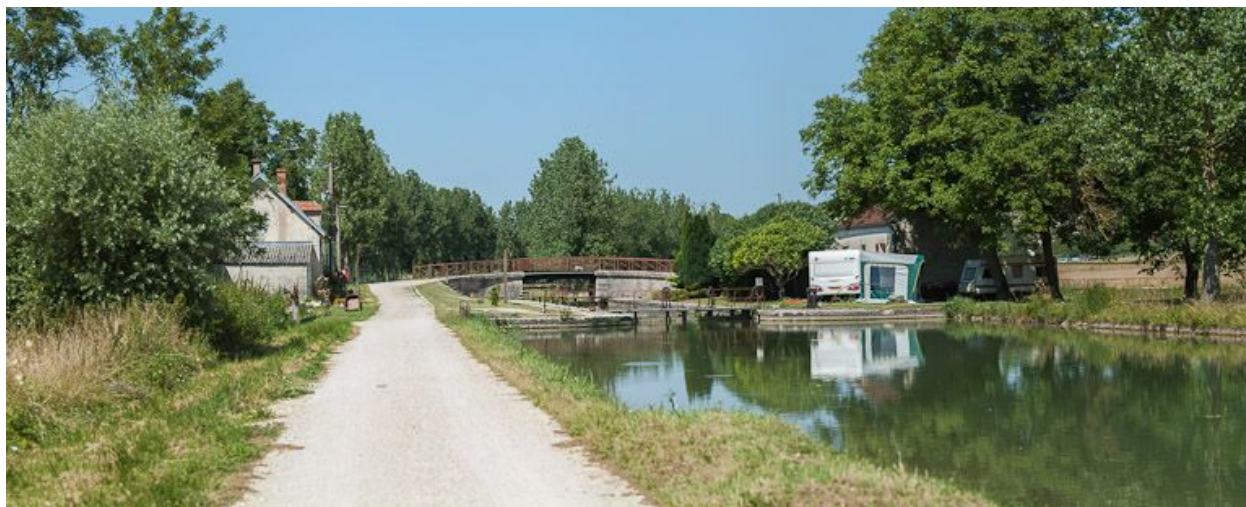
Site d'écluse vu d'amont.
