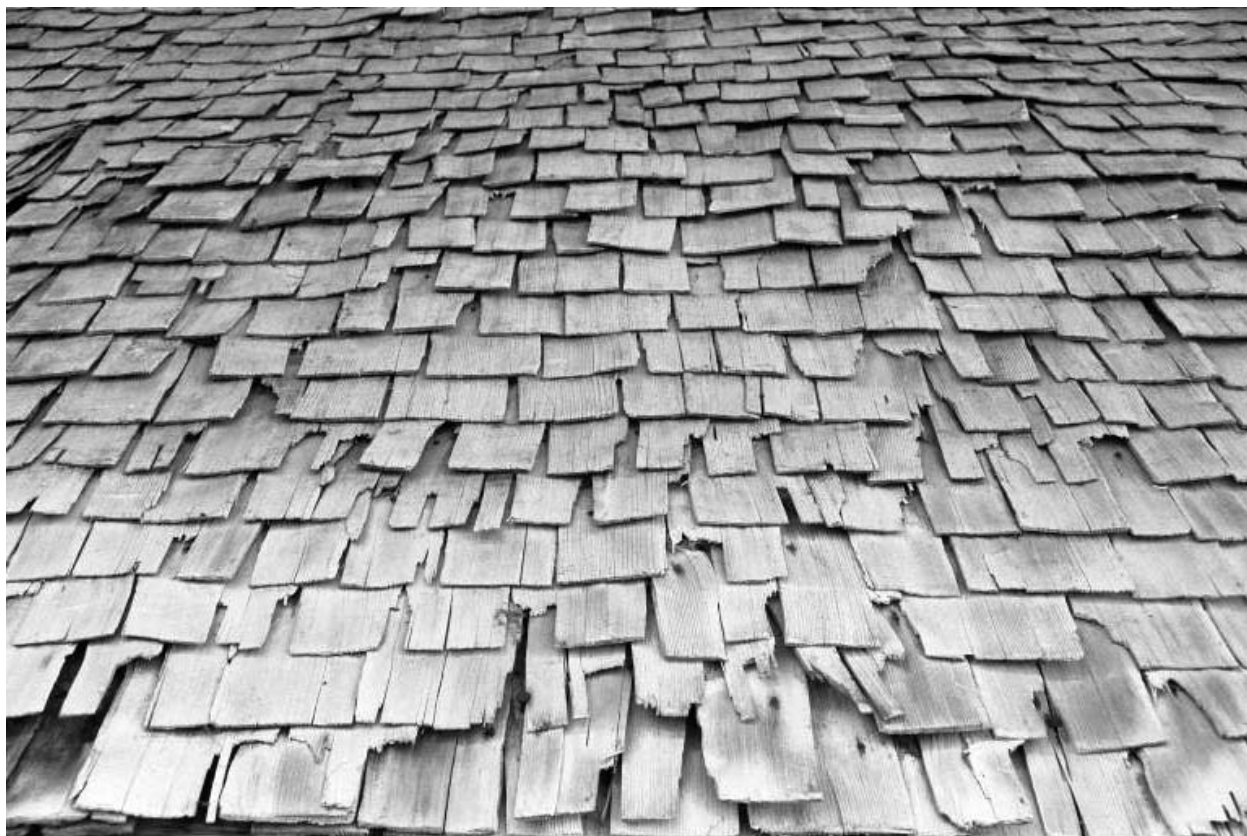
Détail de l'essentage de la façade antérieure.
