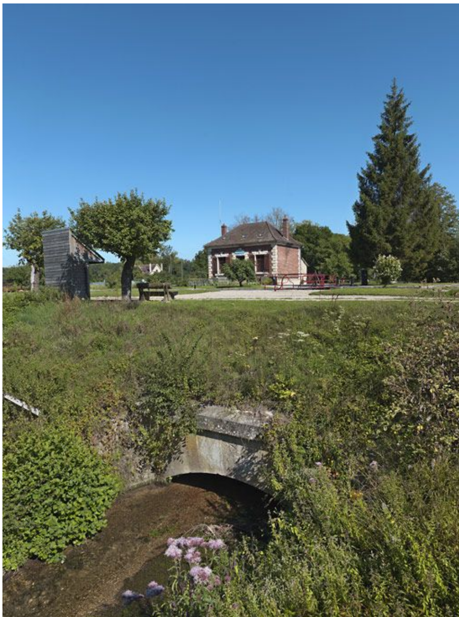
Sortie de l'aqueduc.
