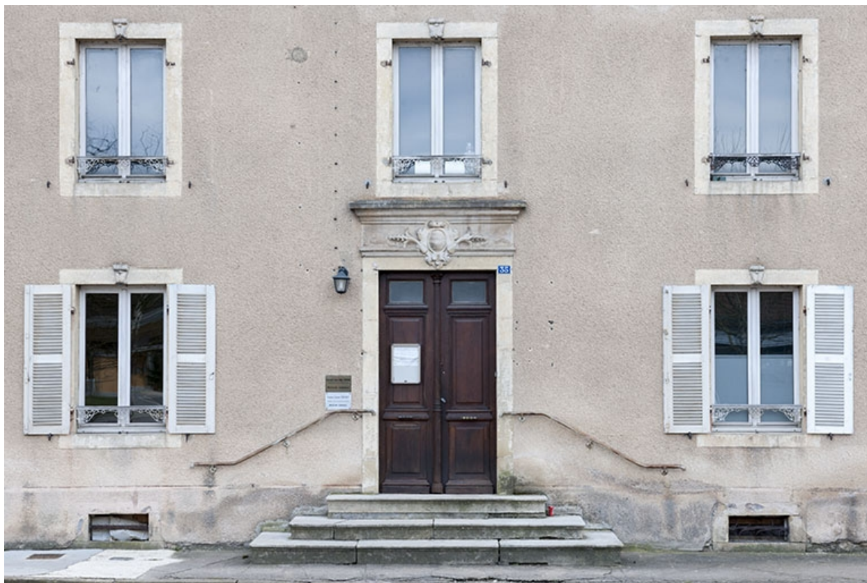
Façade antérieure : baies.
