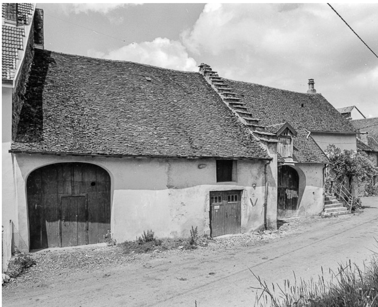
Ferme située rue Chateraine : façade antérieure.
