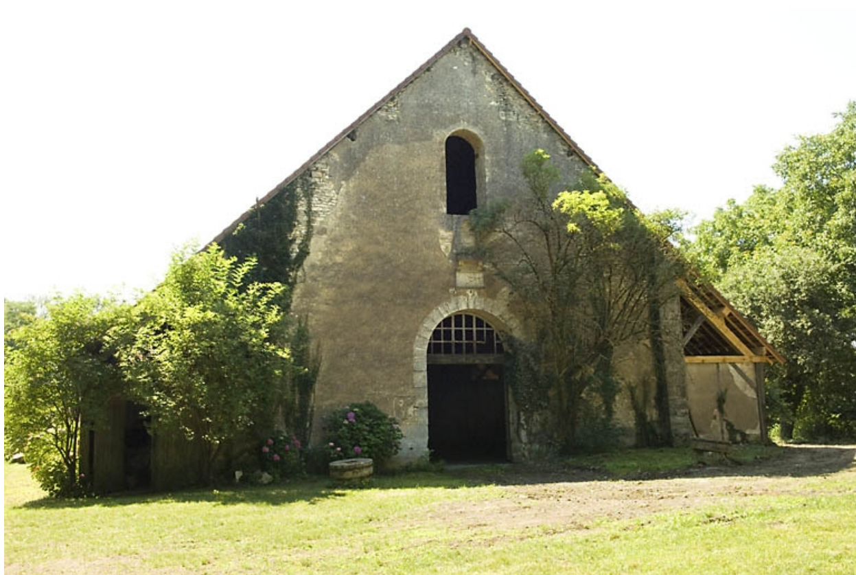
Mur-pignon nord de la halle à charbon.
