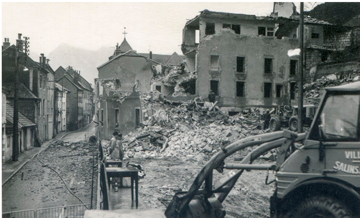
Démolition des bâtiments, vers 1973.
