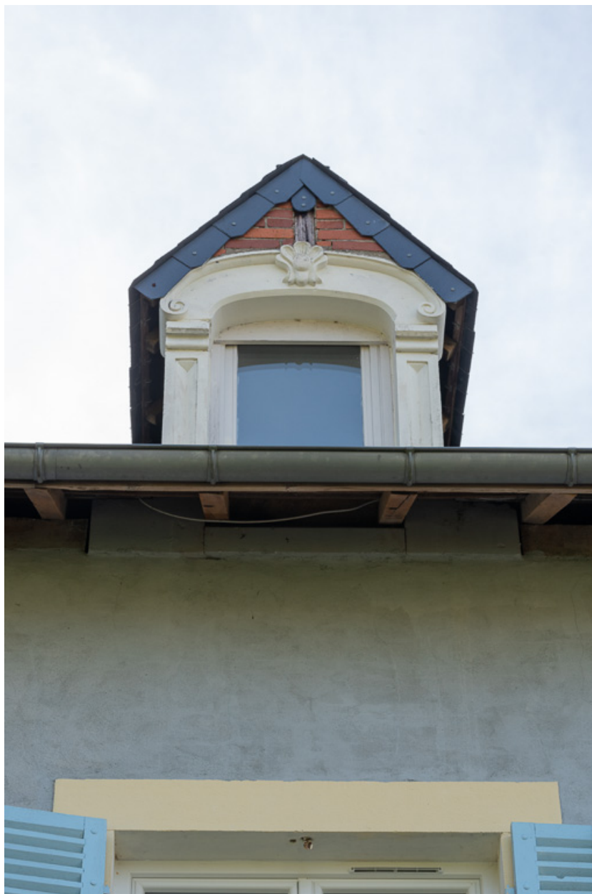
Lucarne de la façade nord-ouest.
