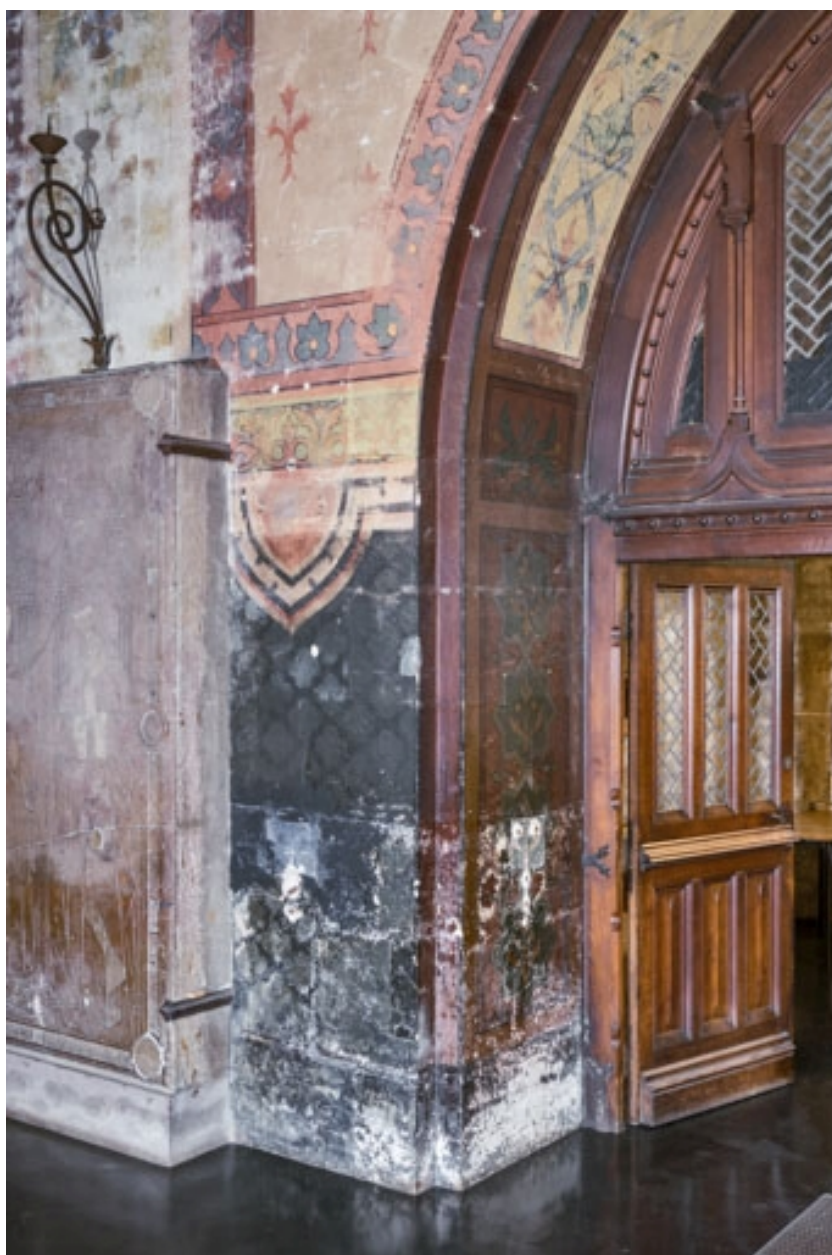
Nef, mur sud (2022) : peinture monumentale.
