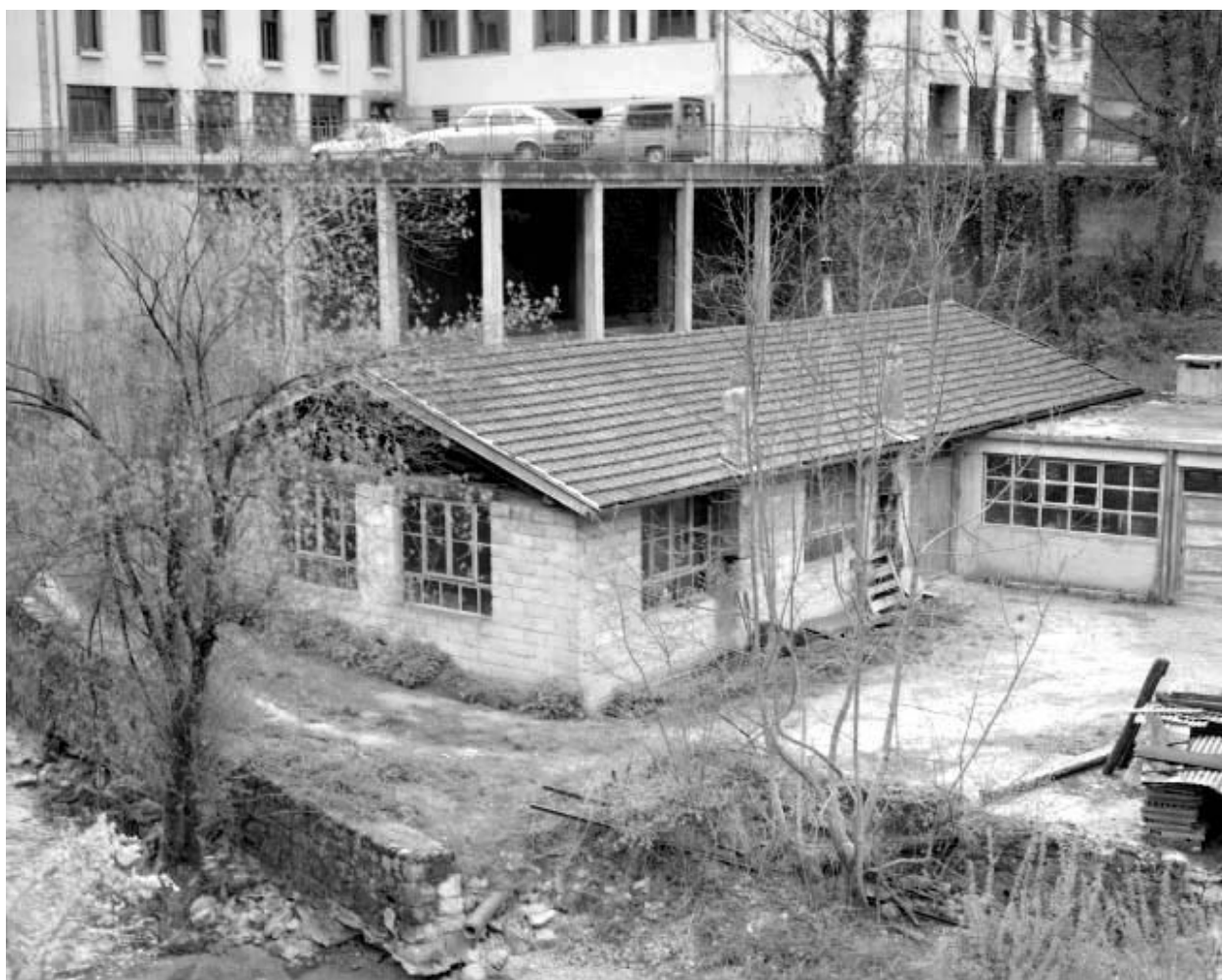
Atelier de fabrication et chaufferie de 1941.
