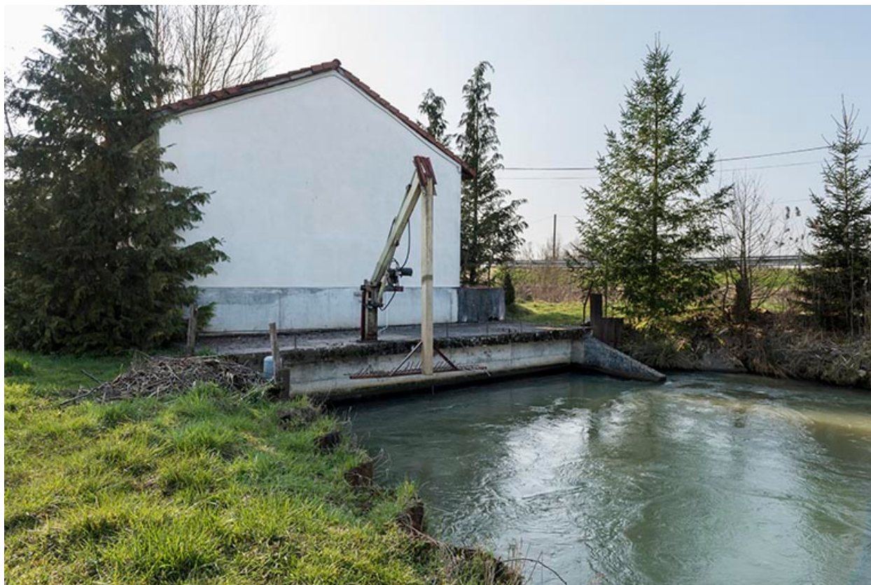
Appareil lié à l'entretien du bief.
