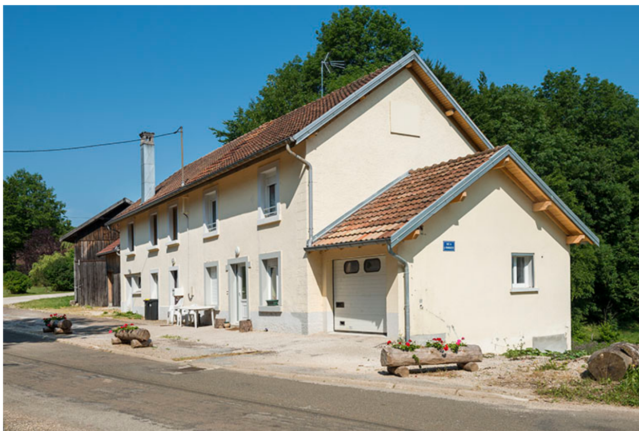
Façades antérieure et latérale droite.
