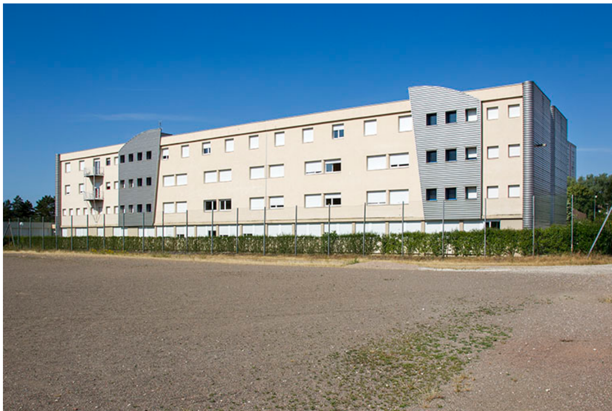
Façade est et pignon nord de l'internat.
