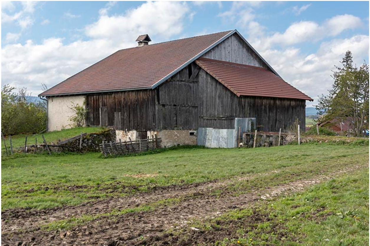
Façades postérieure et latérale droite.
