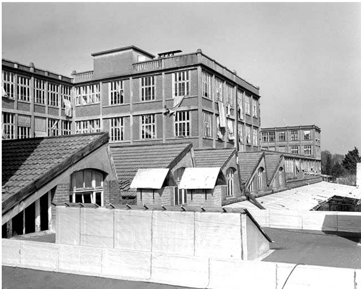
Façade postérieure et sheds.
