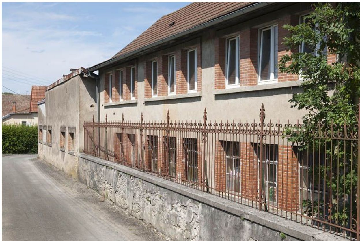
Façade ouest d'un bâtiment industriel (atelier).
