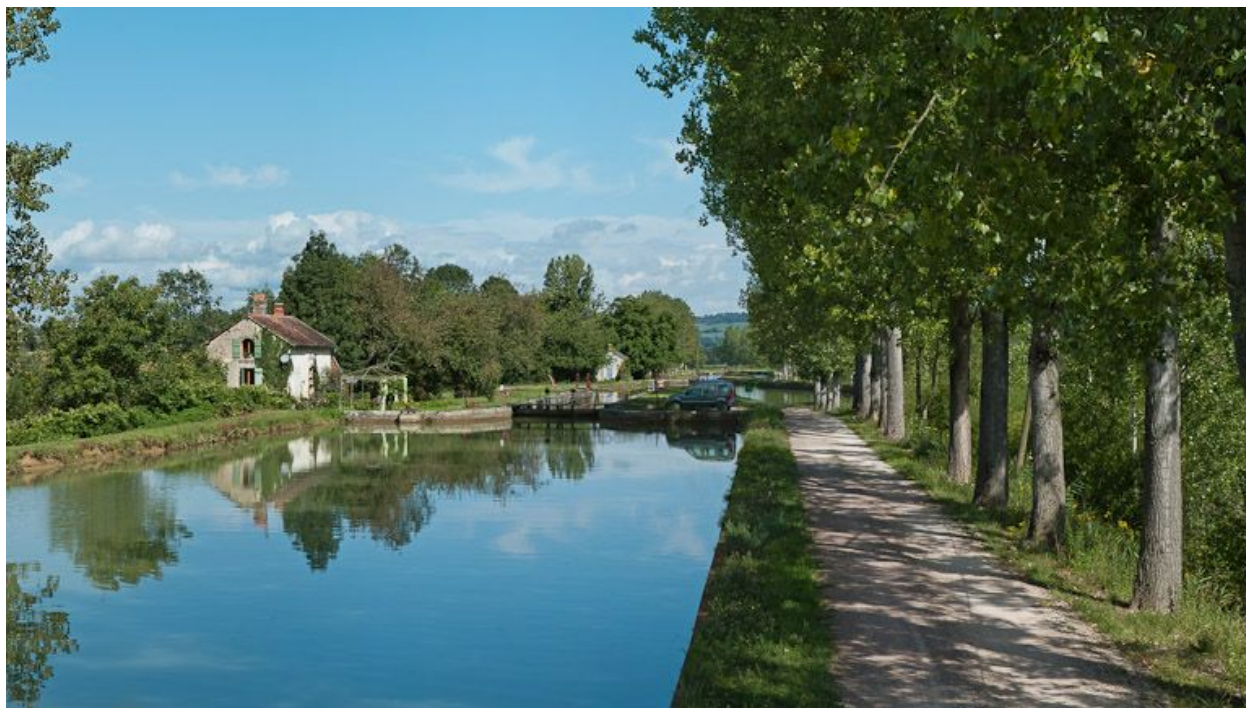
Vue du site d'écluse depuis l'amont.
