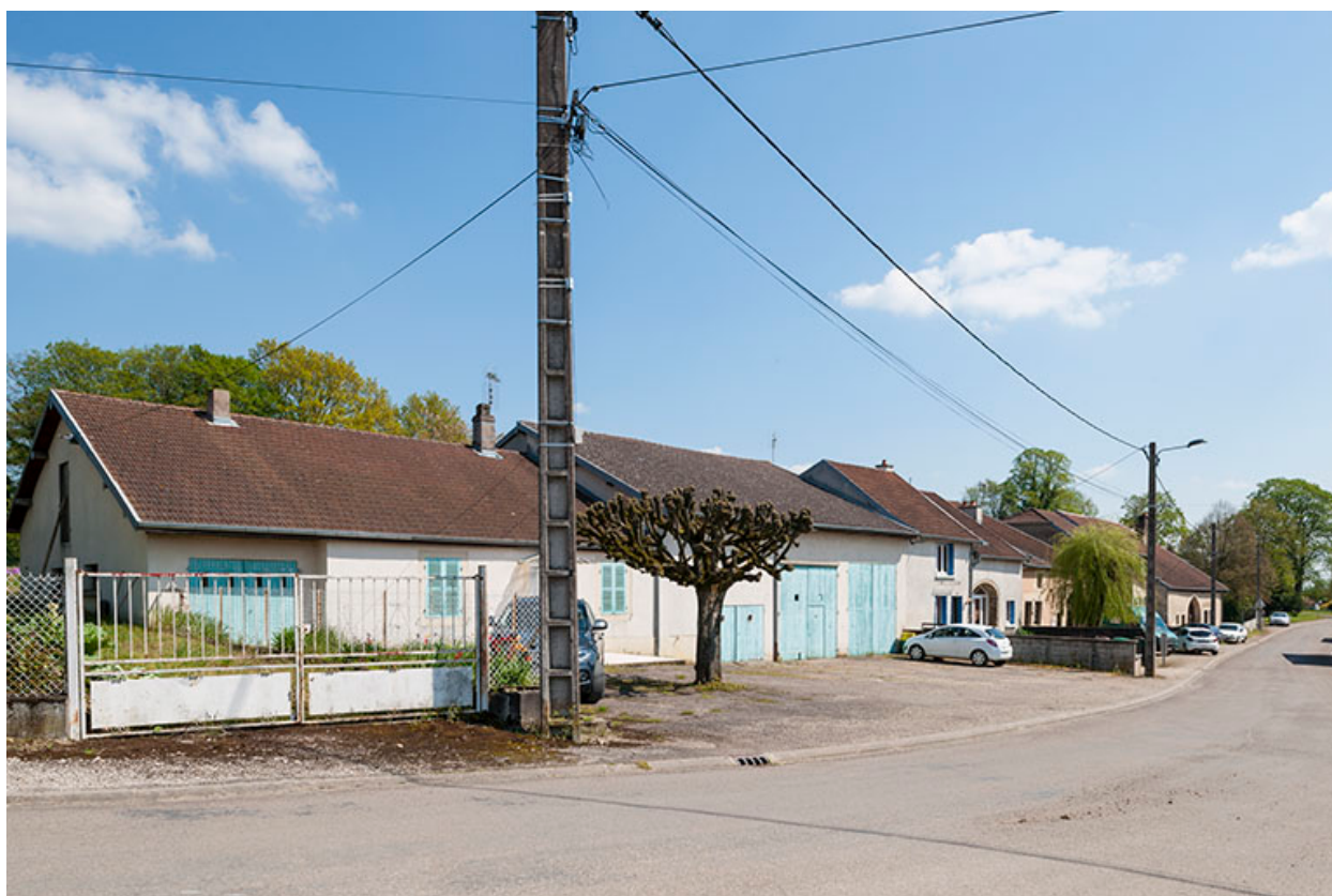
Maisons construites, rue du Patis.
