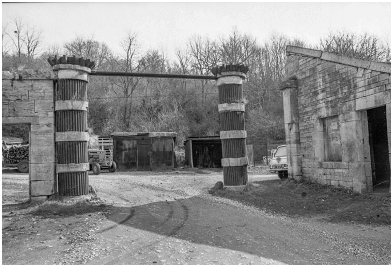
Portail de l'usine, depuis la cour, en 1979.
