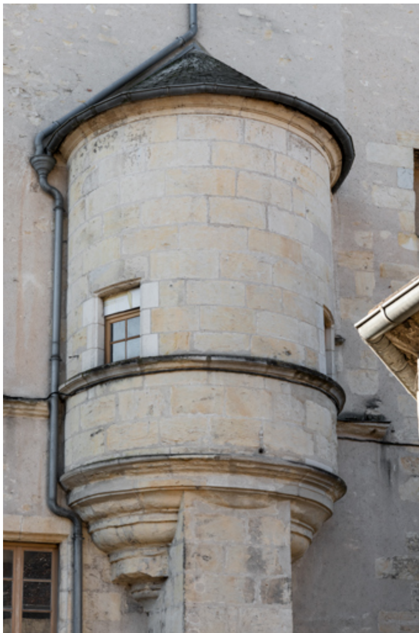
Façade postérieure : échauguette.
