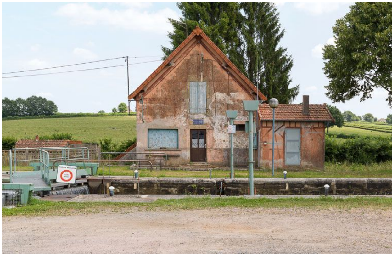
La maison éclusière de face.
