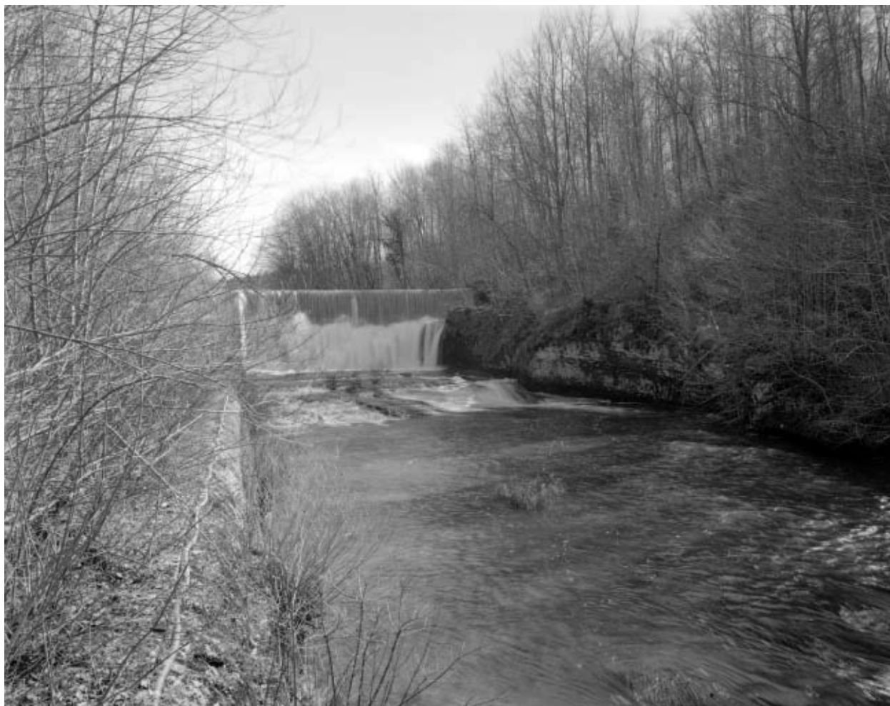
Barrage à crête déversante sur l'Angillon.
