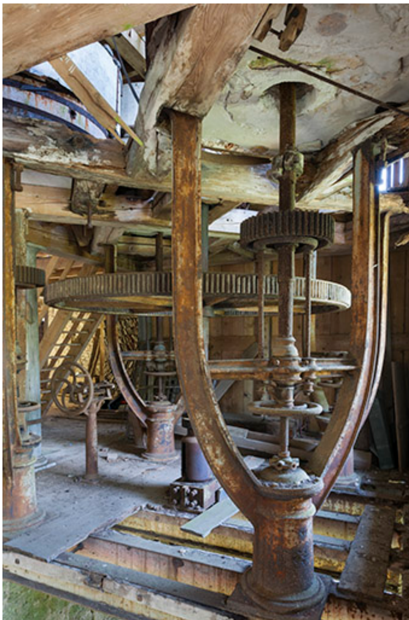
Rez-de-chaussée. Les colonnes "en lyre" du beffroi.
