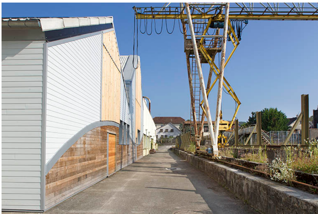
Ateliers : façade antérieure.
