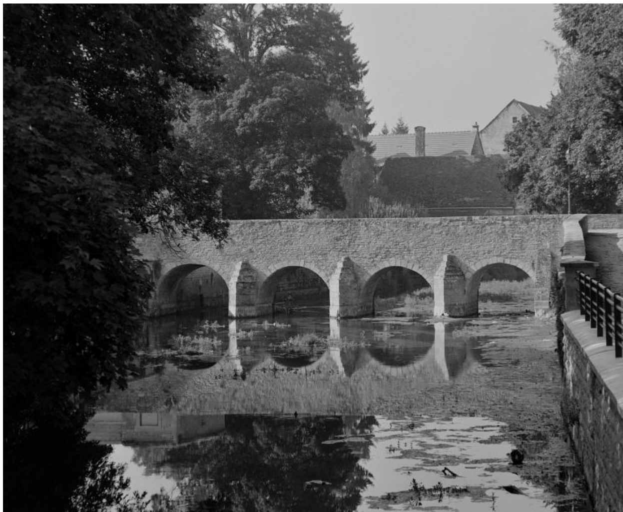
Vue d'ensemble prise en aval
