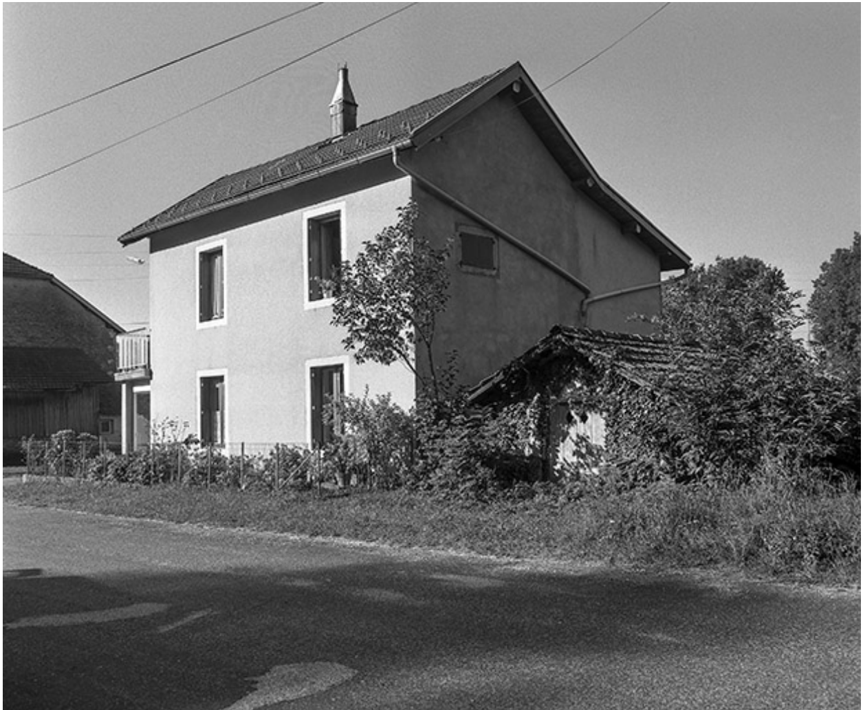
Logement de contremaître.
