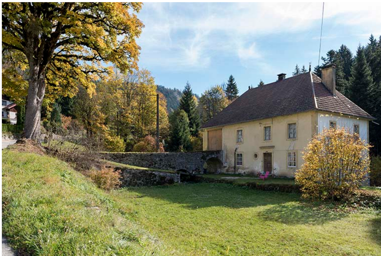
Vue d'ensemble rapprochée, depuis le nord-ouest.
