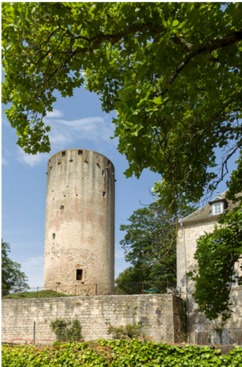
L'ancienne entrée du donjon vue depuis l'est.
