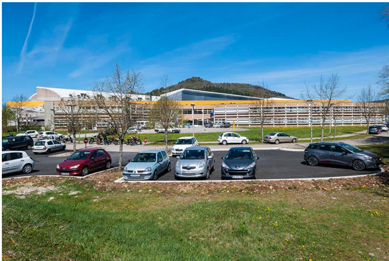
Entrée sud du site.
