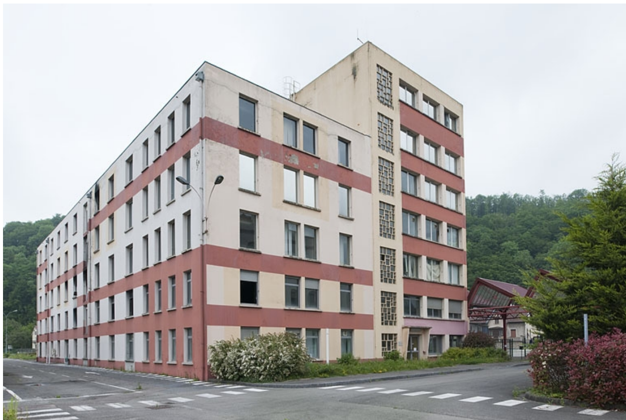
Bâtiment administratif. Vue depuis l'ouest.
