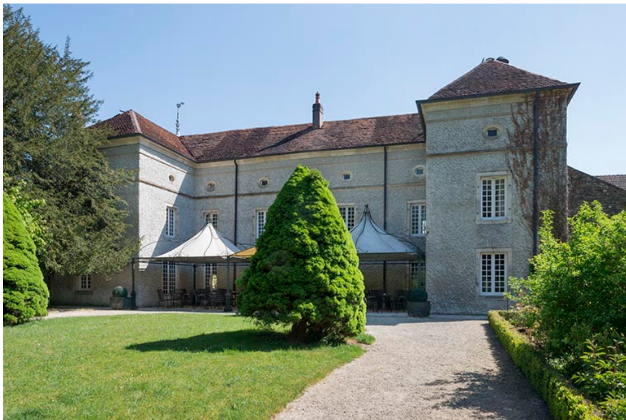
Vue générale, façade postérieure.
