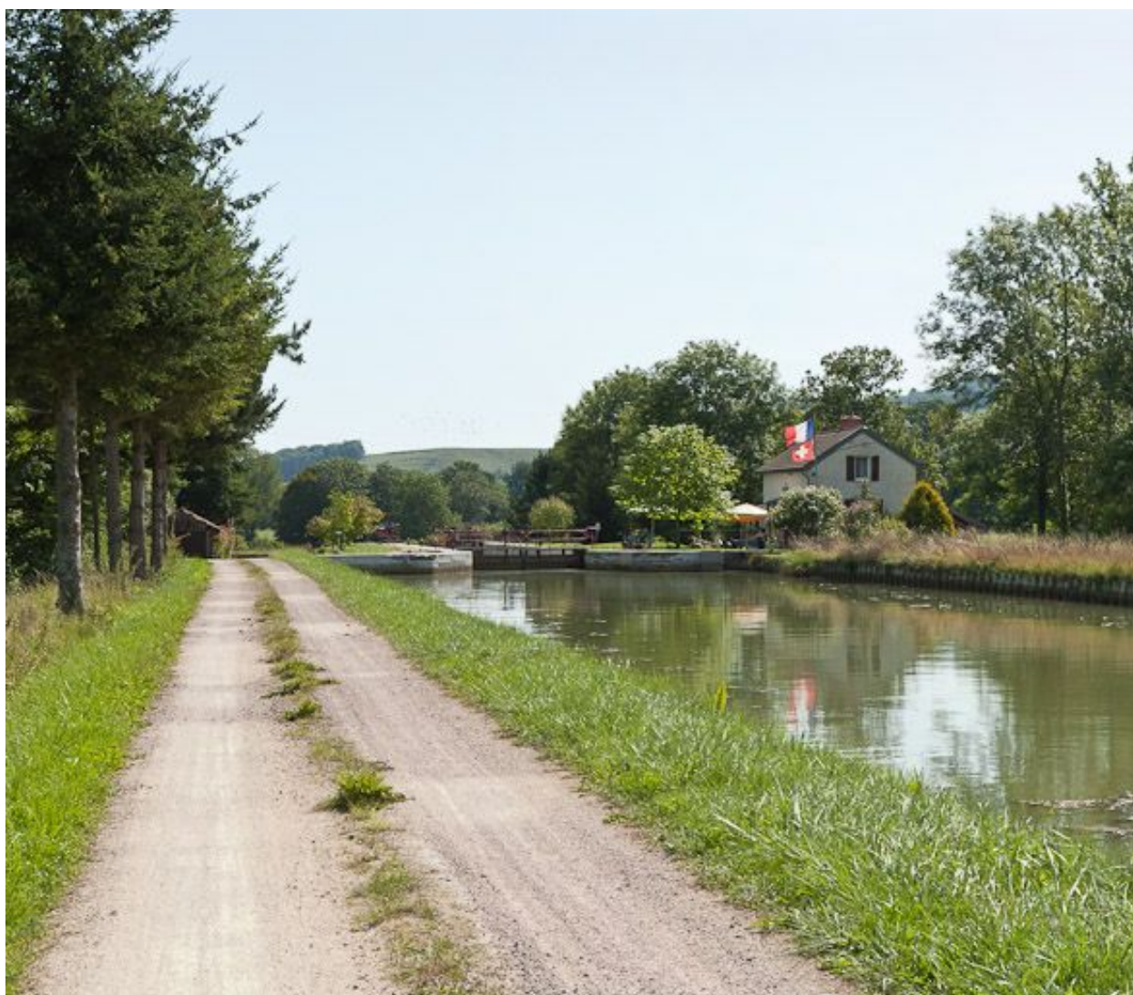
Vue du site d'écluse en amont.
