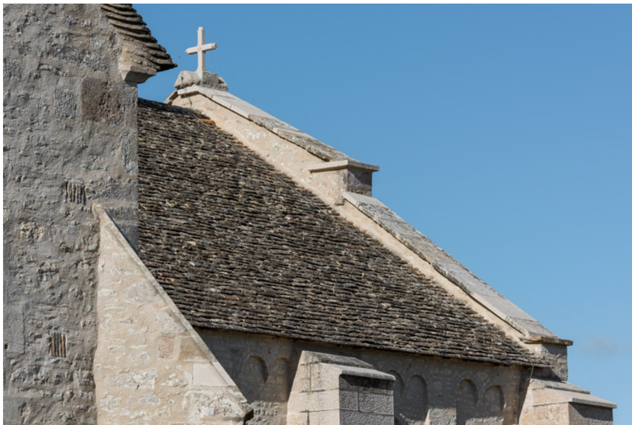
Couverture de la nef.
