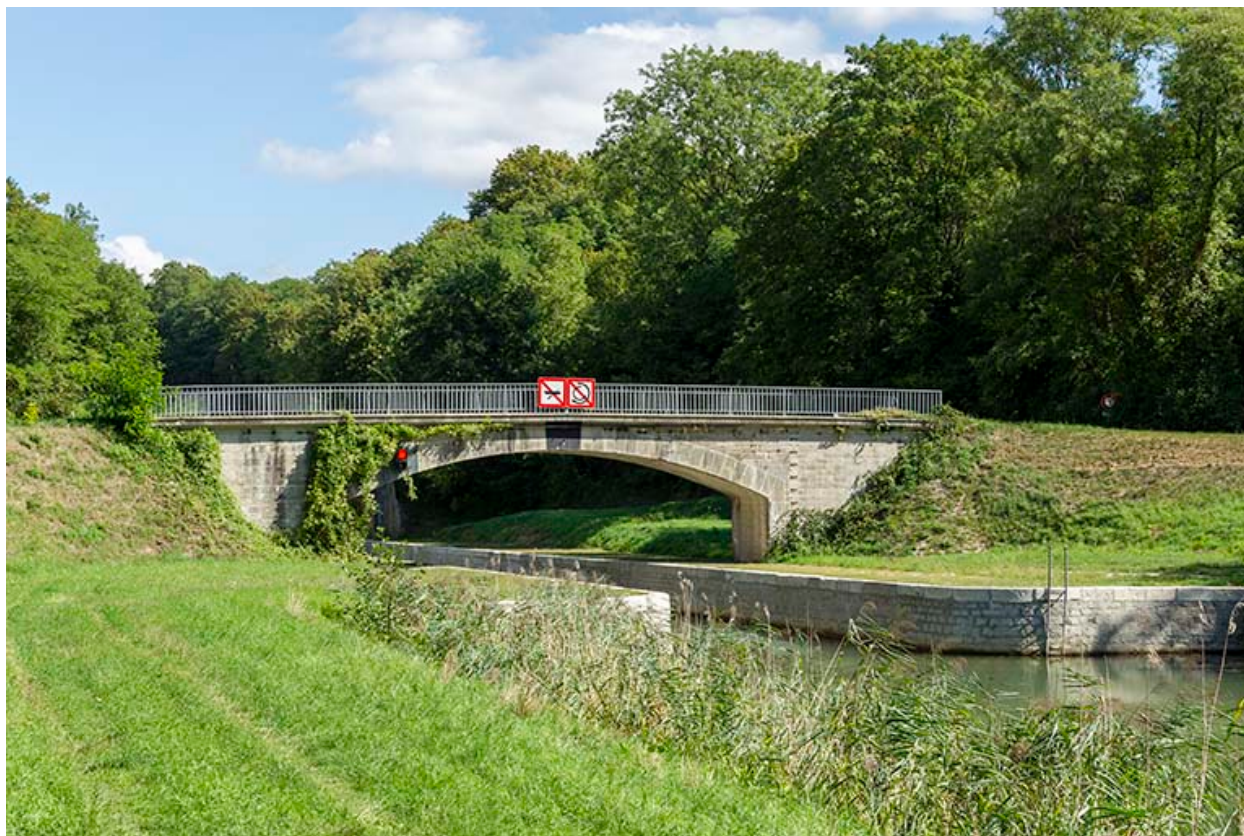
Pont routier en aval du tunnel.
