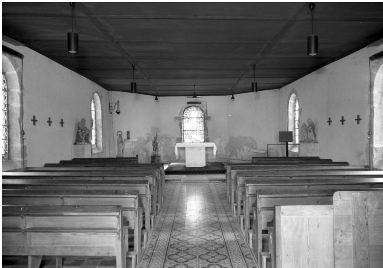
Vue intérieure prise de l'entrée
