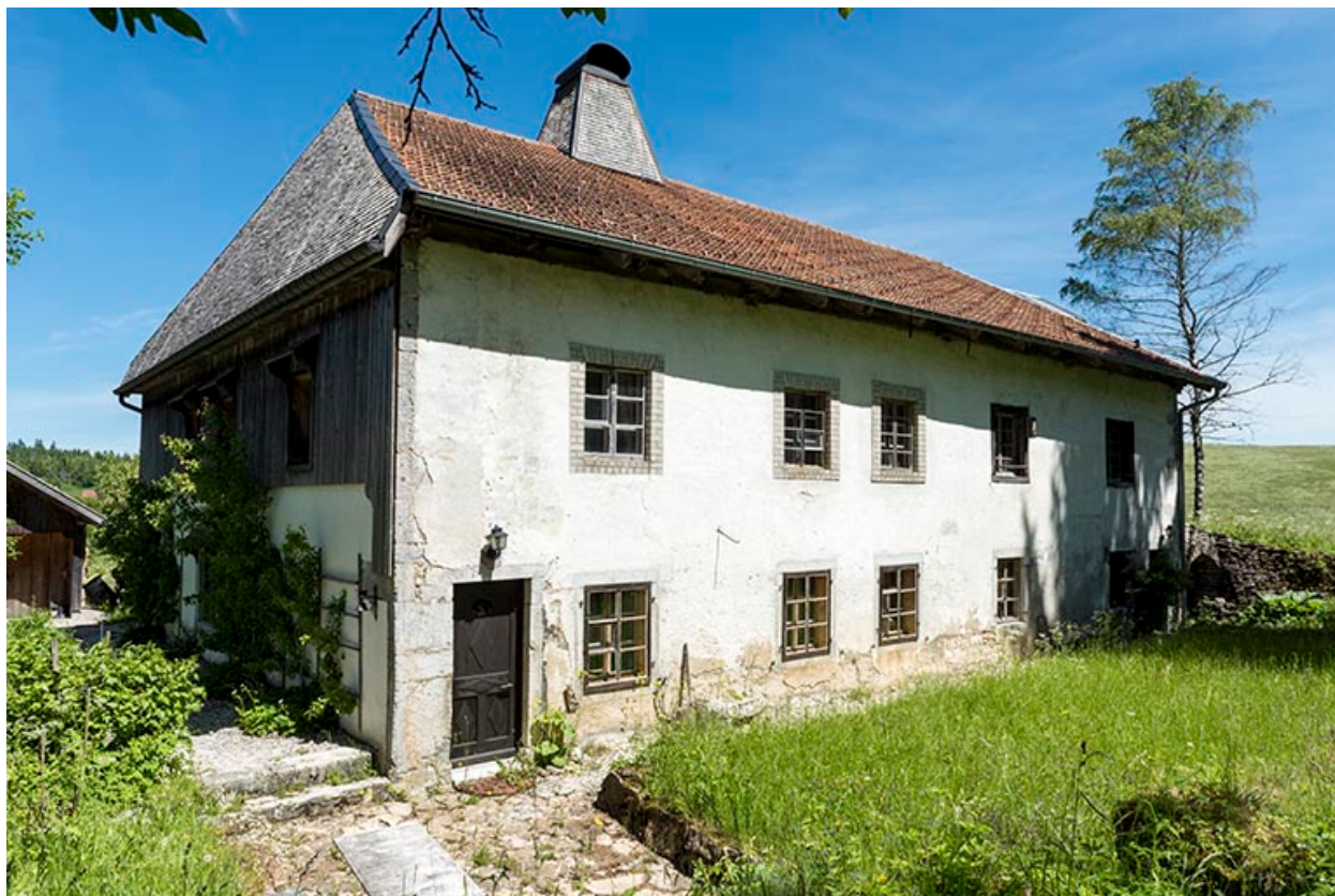
Façade sud, de trois quarts gauche.
